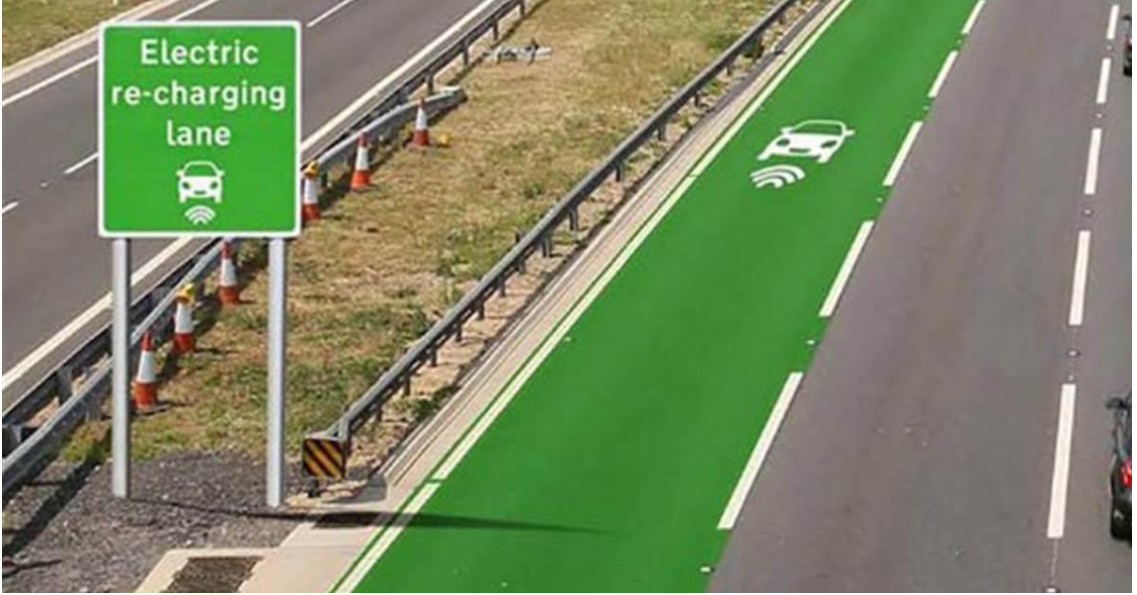
Şekil 9. Araçların seyir esnasında kullanımı için tasarlanmış akıllı yol kablosuz şarjı [16]
